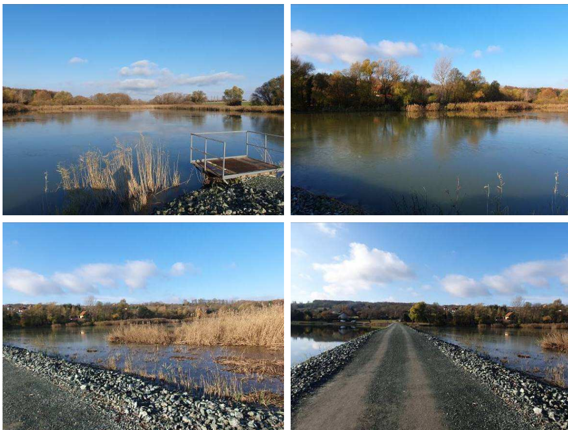
A 0389/11; 0347/1 hrsz Felső tó és a két tavat elválasztó gát fényképei (2023. december)
